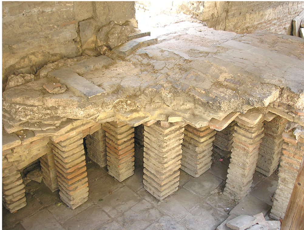
Ausgrabung einer römischen Hypokauste einer alten Therme in Arles (Frankreich)
